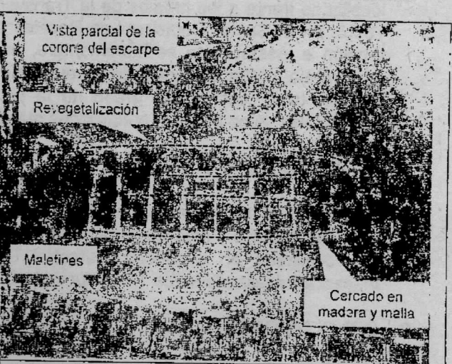
Fotografía 4. Vista parcial de la corona del escarpe, cercado madera rolliza y malla y maletines distribuidos al costado Oriental de la Transversal 2 Este, frente a los predios de la Transversal 2 Este No. 78-13 y Transversal 2 Este No. 78-03.
