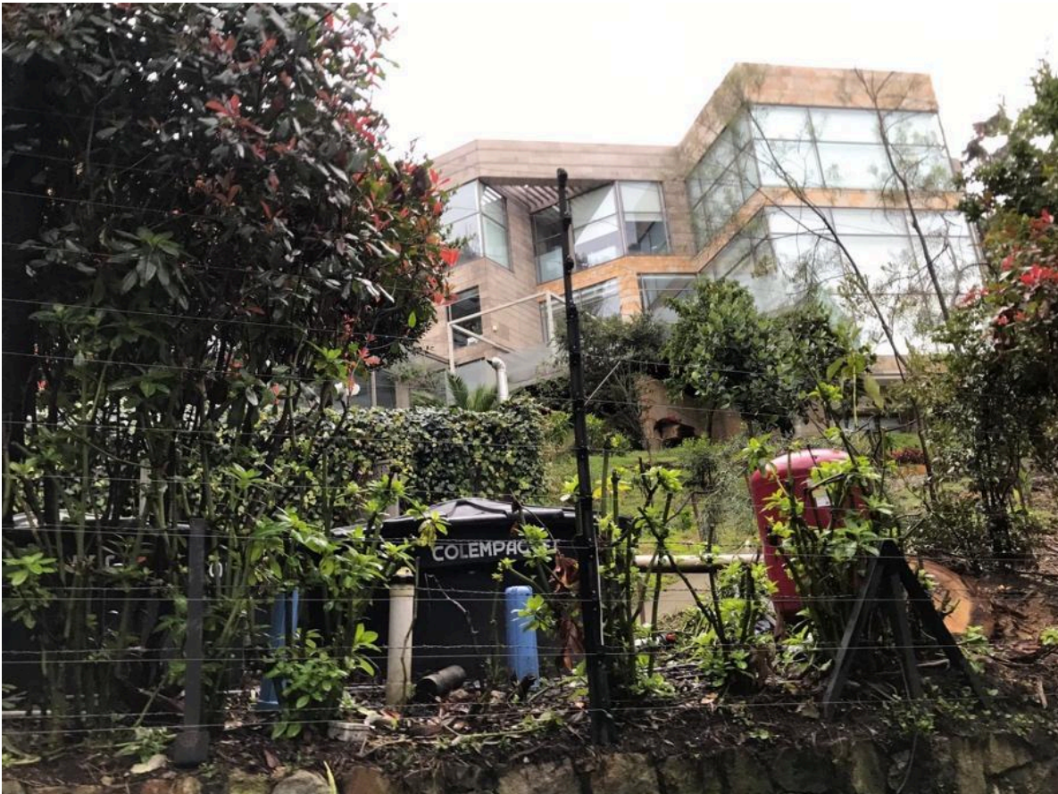
Foto 1: Casa con permiso de tala de la CAR y con orden de demolición
